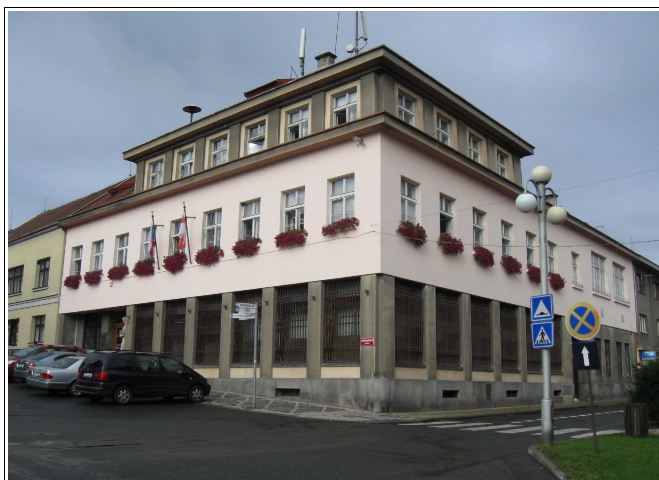
budova MěÚ Nové Strašecí čp. 201
